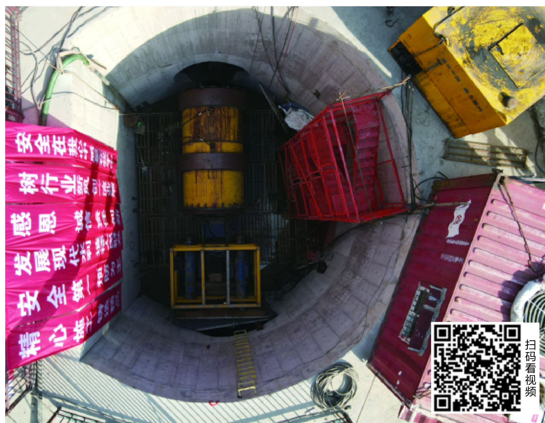
总计32立方米/秒的强排泵站,并沿环城东路、放生池路、东河南路配套建设总长3.7公里、管径2.2
